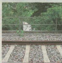
Unterm Gleis hindurch bei Netzeband.
