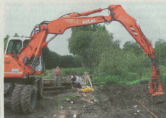
Hinter Katerbow wird eine neue Brücke über die Temnitz gebaut.
